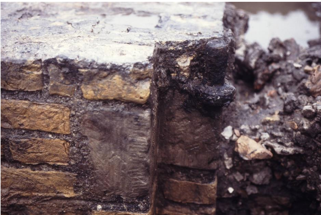
Foto: Detail waarop het scharnier van een deur draaide.
